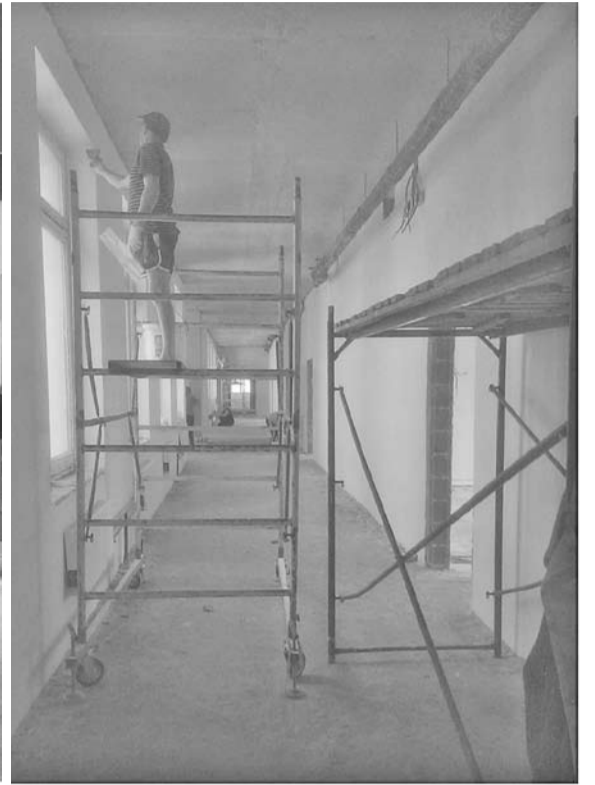
В здании Супоневской школы уже ведутся отделочные работы
